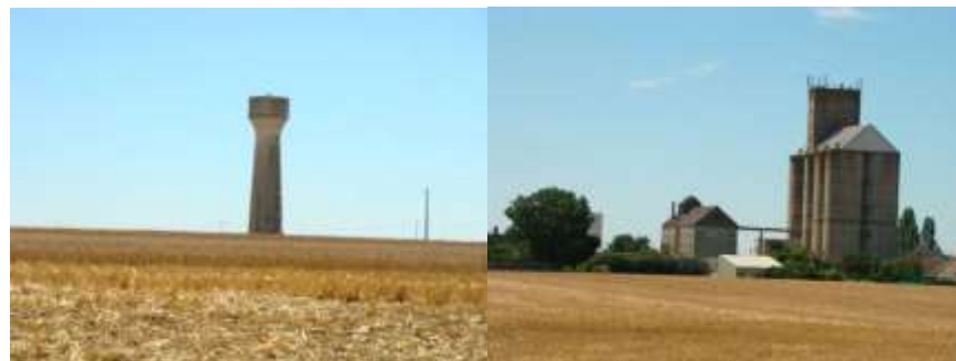
Château d'eau - Charonville
