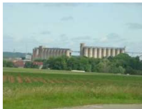
Silos – Commune de Courville-sur-Eure
